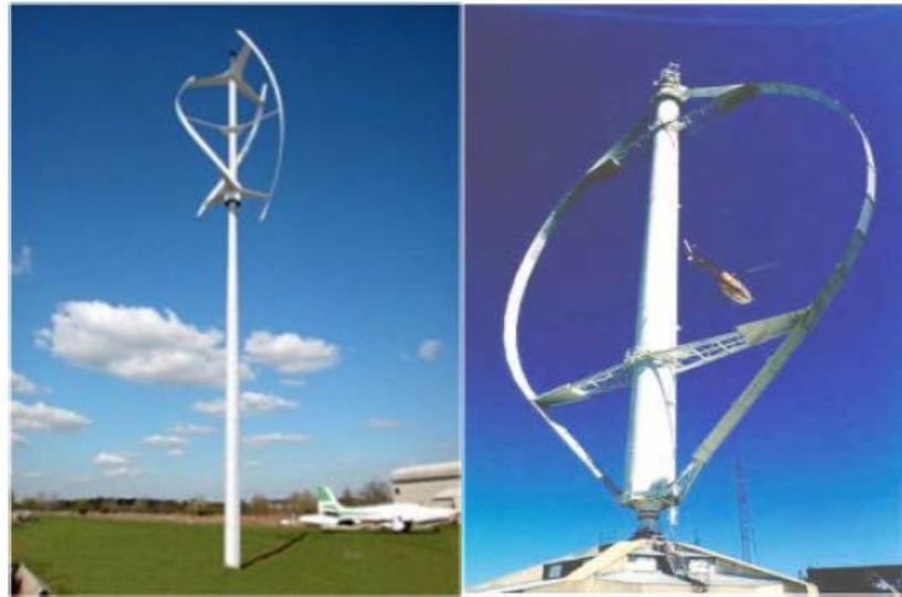
Figure I. 4. Eolienne à axe vertical (Structure Darrieus) [9]
