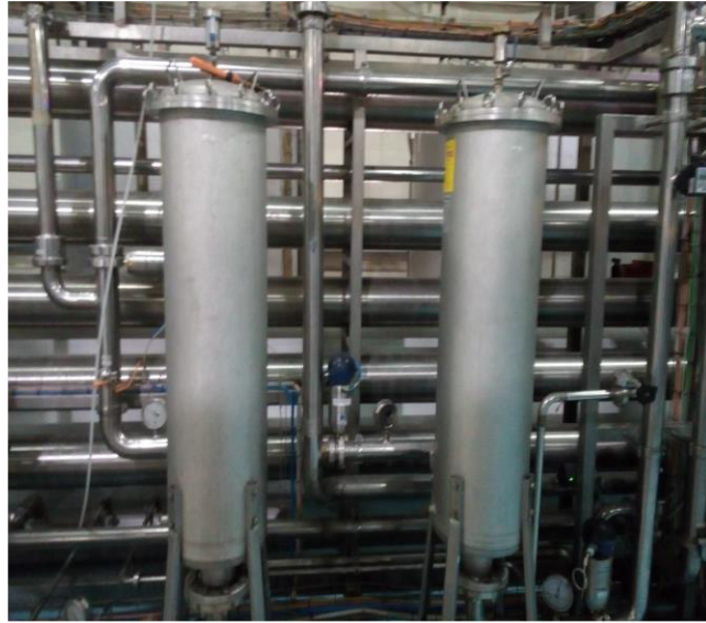
Figure 8 : filtres à cartouches à gauche 5 \mu m et à droite 1 \mu m.
