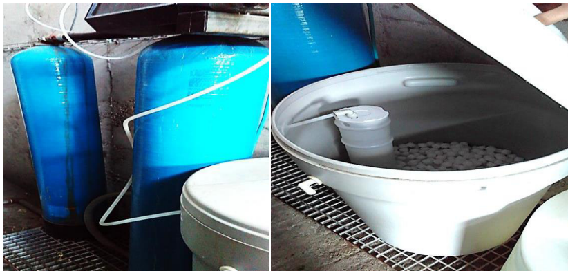
Figure 10: Adoucisseurs et bac à sel.
