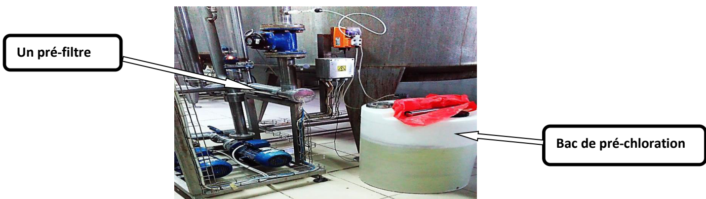
Figure7 : le traitement par une pré filtration et une pré-chloration.
