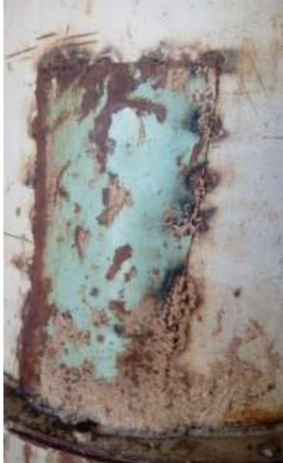
Figure III. 3. Etat de la tuyauterie (trouée et cabossée par endroit).
