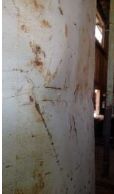
Figure III. 3. Etat de la tuyauterie (trouée et cabossée par endroit).
