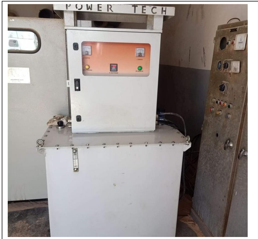
Figure II.5 : Transformateur-redresseur P-DH- 100-100
