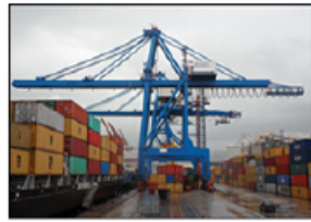
Grue de quai (QC)
