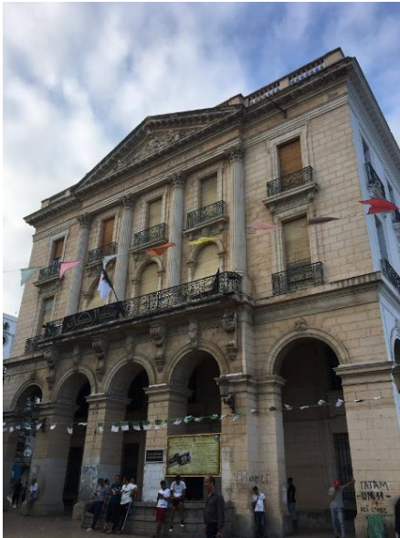
Figure 29 : Cinéma de Béjaïa (Entrée au sous-sol). Source : Google Maps. (Consulté le 02/07/2021)
