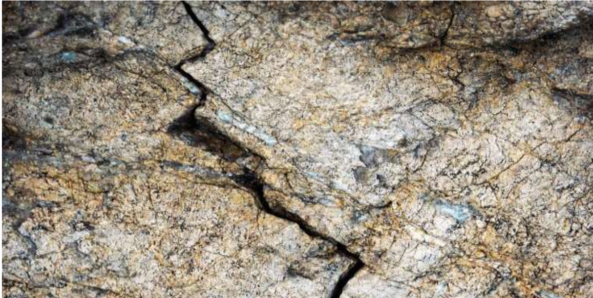
Figure II.5: Exemple d'une fissure (Image de Ahojdoma)
