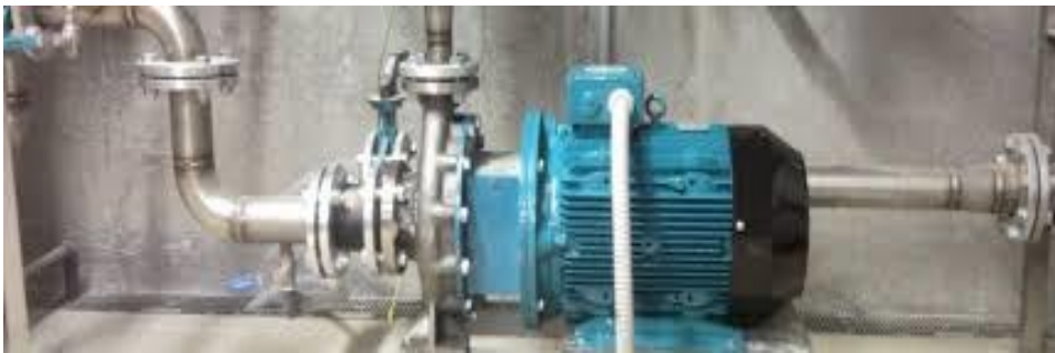
Figure I.7 : Pompe centrifuge.
