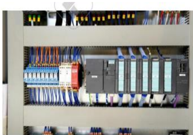
Figure II.6 : Automate programmable de type modulaire (siemens).
