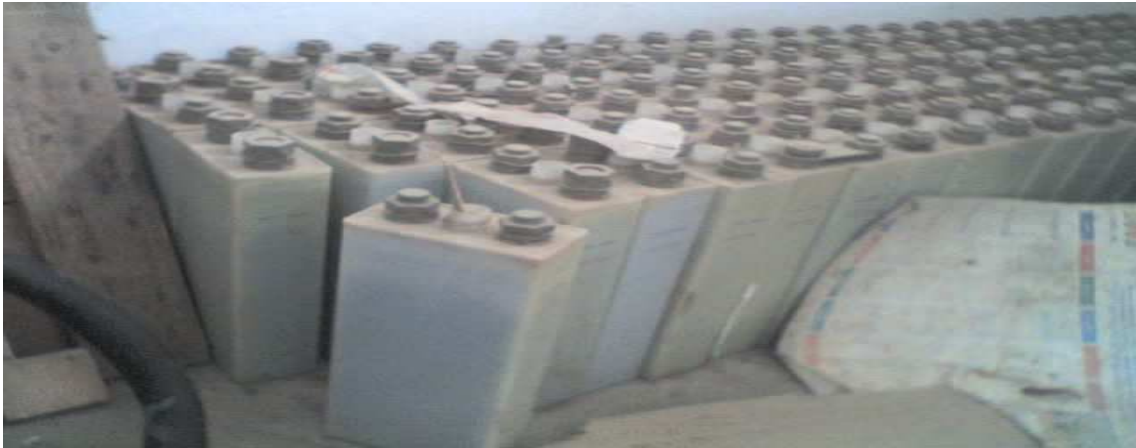
Photo N°1 : Stockage des batteries cadmium-nickel à la RTC
