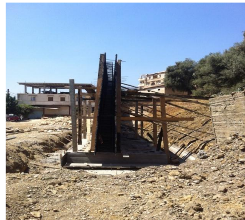
Figures 5.37 Réalisation d'un mur en béton armé en aval du glissement
