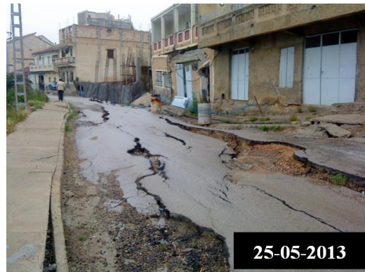
Figures 5.17 Evolution des dégradations observées sur la chaussée
