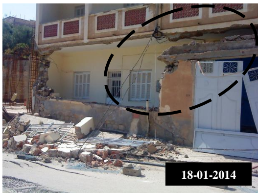
Figures 5.16 Evolution de dégradations observées sur la bâtisse en amont
