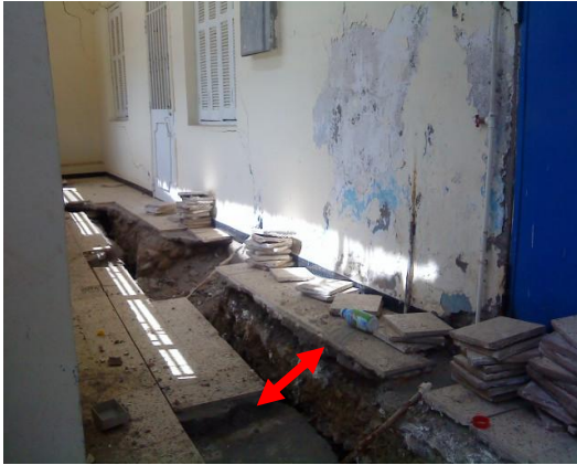
Figures 5.13 Escarpement d'environ un mètre
