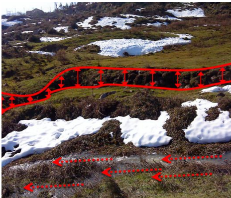
Figure 1.34 : Affaissement du terrain au-dessus du ruisseau
