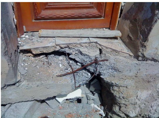
Figures 5.12 Torsion de la longrine et renversement du mur de soutènement dû à la poussée du terrain
