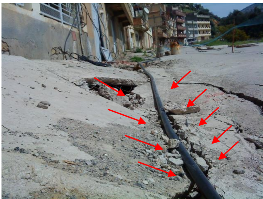
Figures 5.14 Fissures de traction ou de régression
