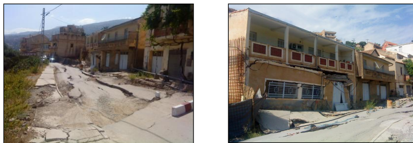
Figure 1. Vue du glissement de Bouhlou (Sidi Aïch)
