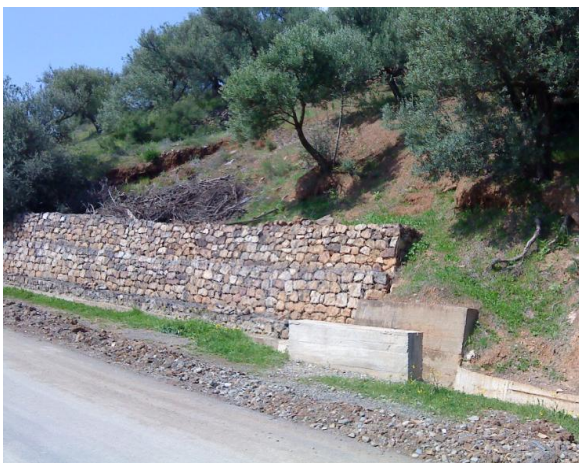
Figure 1.28 : Ouvrage souple, en gabion Sidi Younes, Ouzellaguen, Béjaïa.
