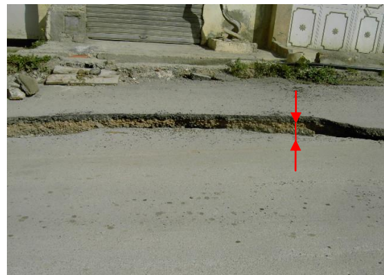
Figures 5.14 Fissures de traction ou de régression
