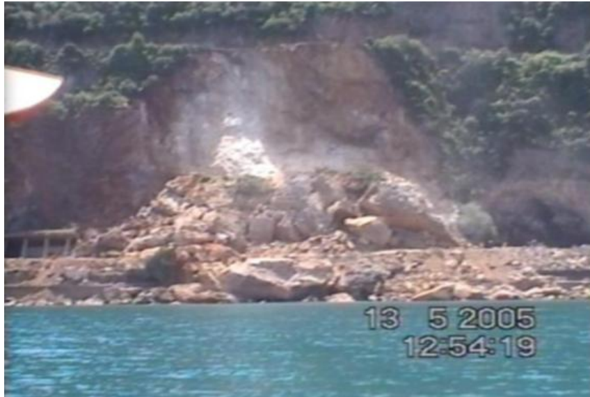
Figure 1.3 : Eboulements à « Aokas » en 2005, wilaya de Bejaia.
