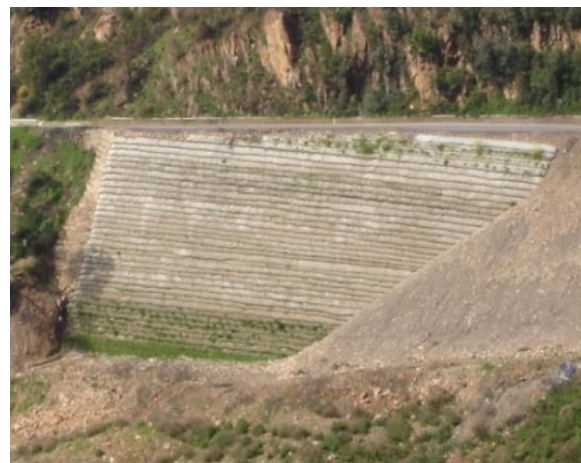
Figure 1.29 : Ouvrage souple, en géotextiles, CW13, Tifra, Béjaïa.
