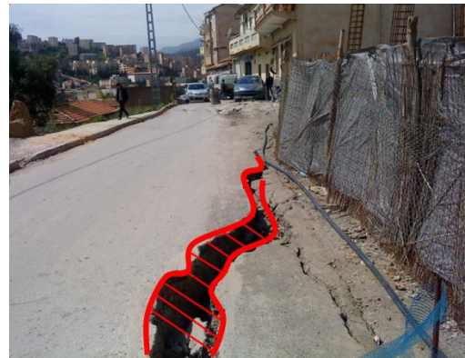
Figures 5.11 Contour du glissement et décrochement profond de la chaussée
