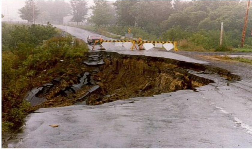
Figure 1.13 : Glissement rotationnel Rivière Bayonne (Québec.) Canada.
