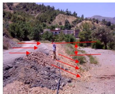
Figure 1.38 : Sens du glissement et affaissement de la route.
