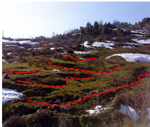
Figure 1.35 : Glissement en forme de gradins
