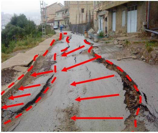
Figures 5.10 Sens du glissement, déplacement latéral et affaissement de la chaussée
