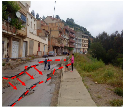
Figures 5.10 Sens du glissement, déplacement latéral et affaissement de la chaussée
