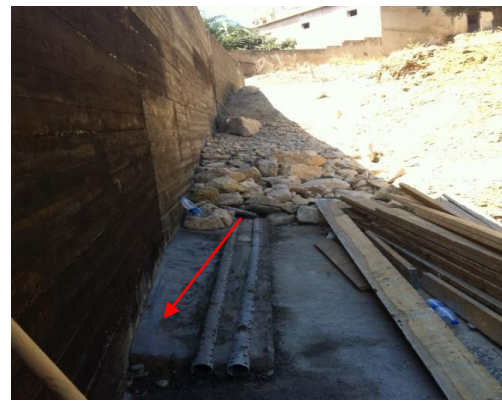
Figures 5.38 Matériaux drainants (type TVO) et tubes perforés, pour le drainage derrière le mur
