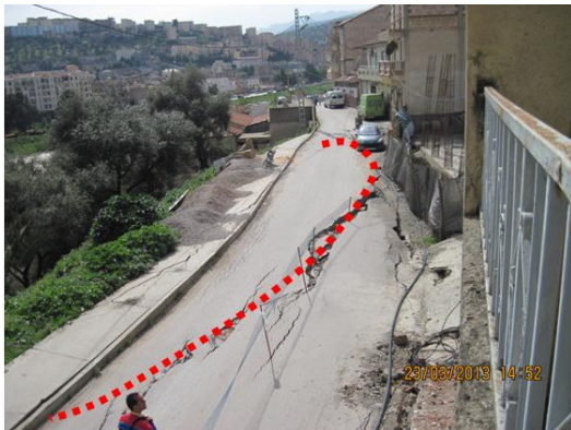
Figures 5.11 Contour du glissement et décrochement profond de la chaussée
