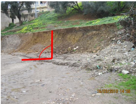
Figures 5.15 Terrassement en aval et Inclinaison des arbres
