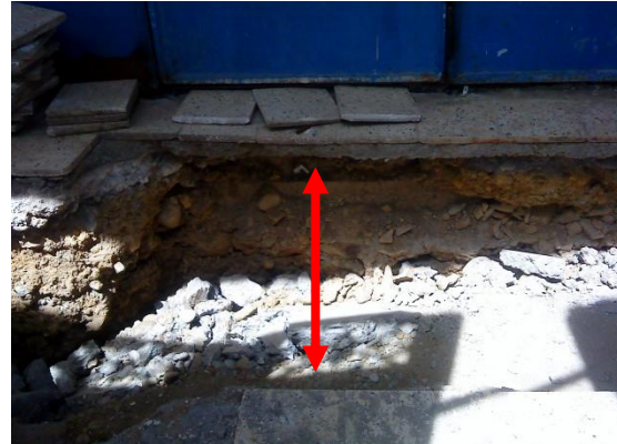
Figures 5.13 Escarpement d'environ un mètre
