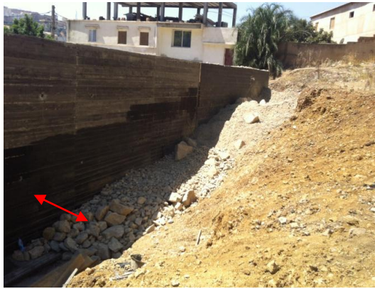
Figures 5.38 Matériaux drainants (type TVO) et tubes perforés, pour le drainage derrière le mur
