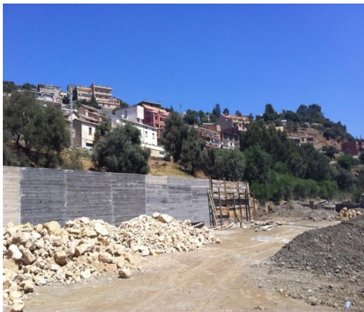
Figures 5.37 Réalisation d'un mur en béton armé en aval du glissement
