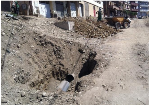
Figures 5.36 Réalisation d'un nouveau système de drainage
