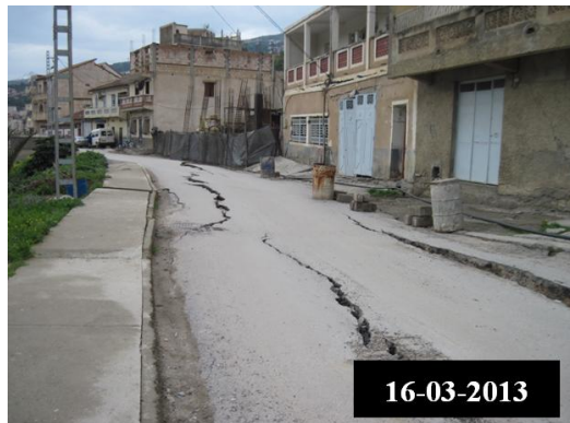
Figures 5.17 Evolution des dégradations observées sur la chaussée
