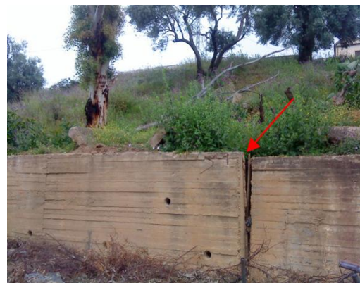
Figures 5.12 Torsion de la longrine et renversement du mur de soutènement dû à la poussée du terrain
